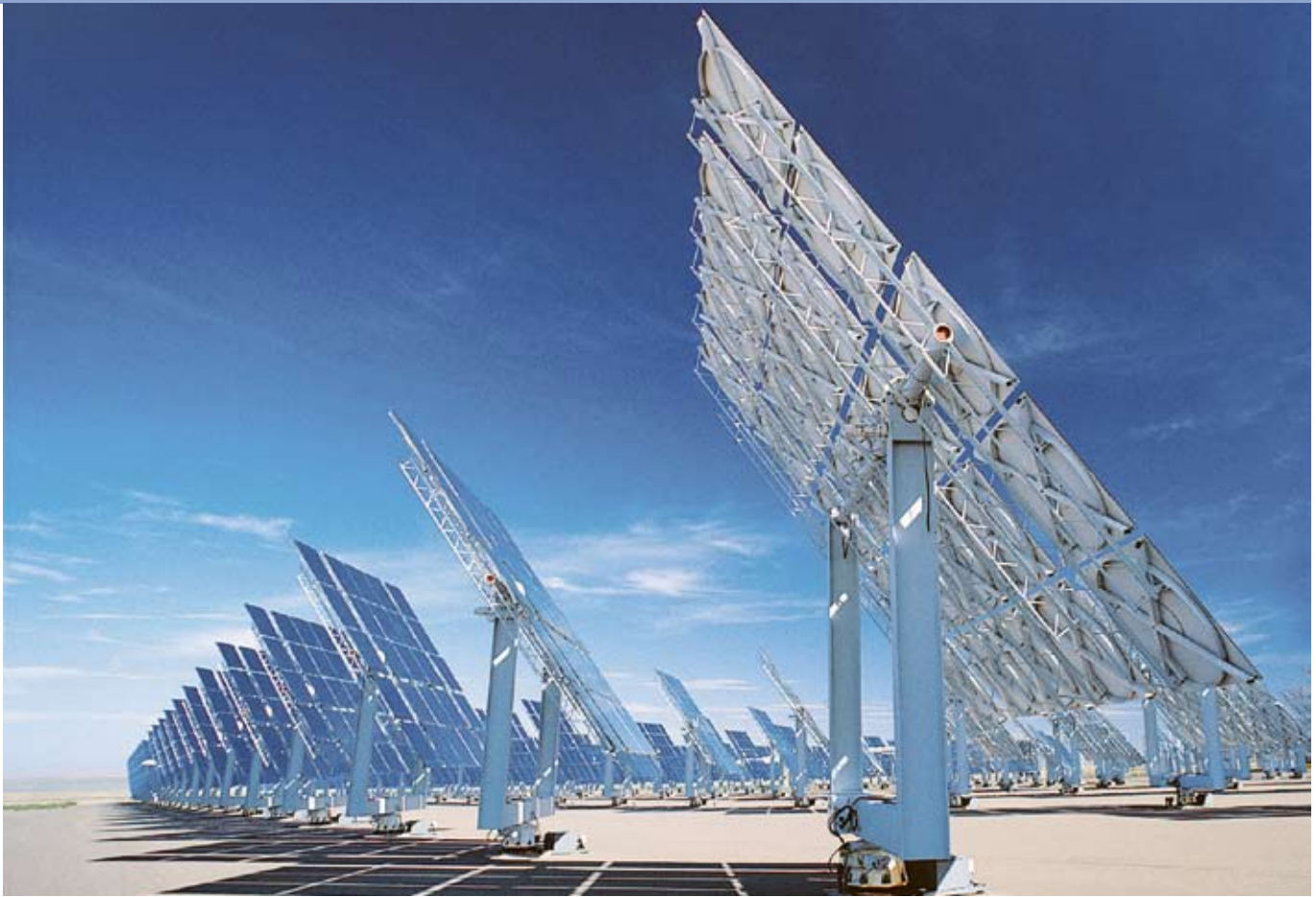
Wüstenstrom aus der Sahara: Grosse Solarparks generieren Strom, welcher mittels HGÜ-Leitungen (Hochspannungs-Gleichstrom-Übertragung) mit geringen Verlusten bis nach Europa geleitet werden. Bei diesen Parks folgen die beweglichen Solar-Module dem Stand der Sonne.
